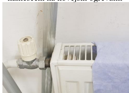
Termostatski ventili niso nameščeni na novejših ogrevalih
