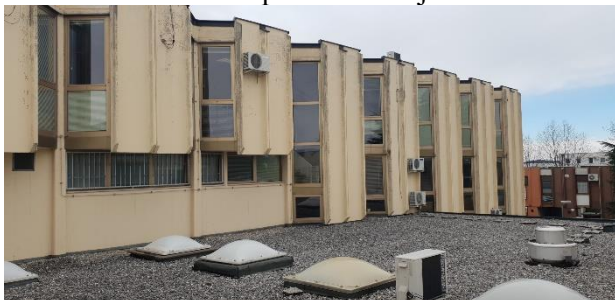
Slika 33: Ravna streha izvedena po sistemu obrnjene strehe.
