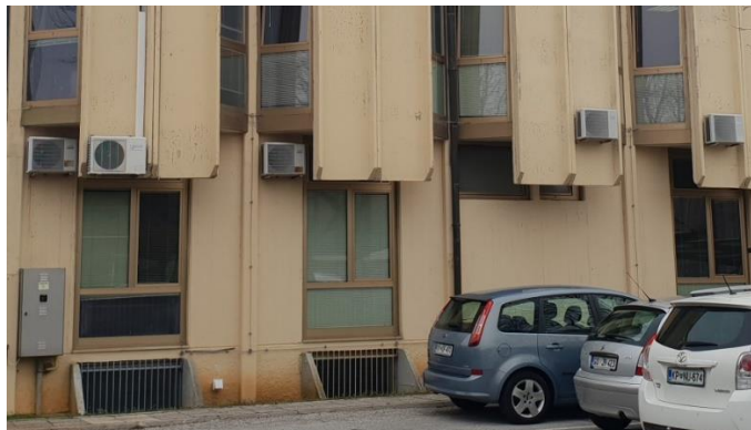
Hladilne enote so nameščene na fasadi
