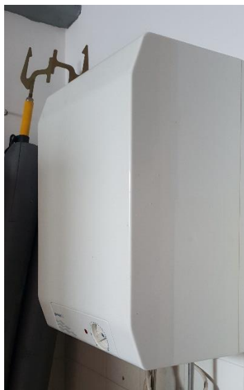
Slika 30: Priprava tople sanitarne vode v celoti poteka lokalno.
