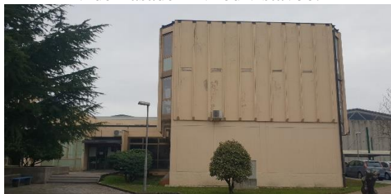
JZ del fasade in poševna AB konstrukcija in konzole – problematična odprava toplotnih mostov.
