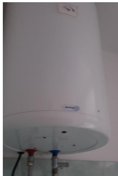
Slika 30: Priprava tople sanitarne vode v celoti poteka lokalno.
