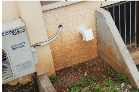
Odvodni kanali za prezračevanje kleti.
