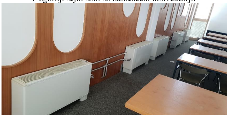
Slika 36: Radiatorski in konvektorski sistem za ogrevanje in hlajenje prostorov.
