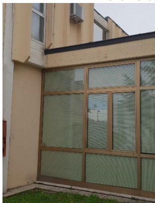
Betonski elementi visijo preko etaže – problematična odprava toplotnih mostov.
