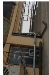
JZ del fasade in poševna AB konstrukcija in konzole – problematična odprava toplotnih mostov.
